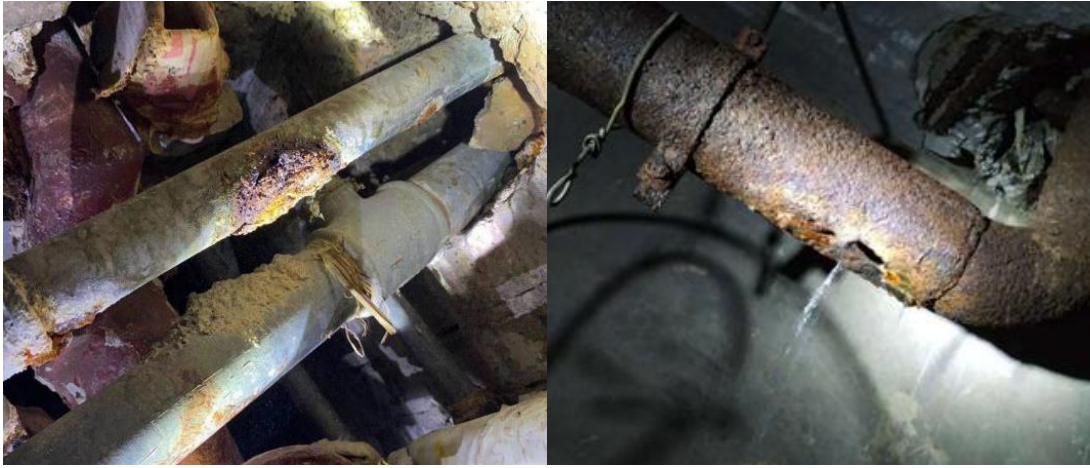
图 11.2 号楼（南楼）内主机电管线年久失修
