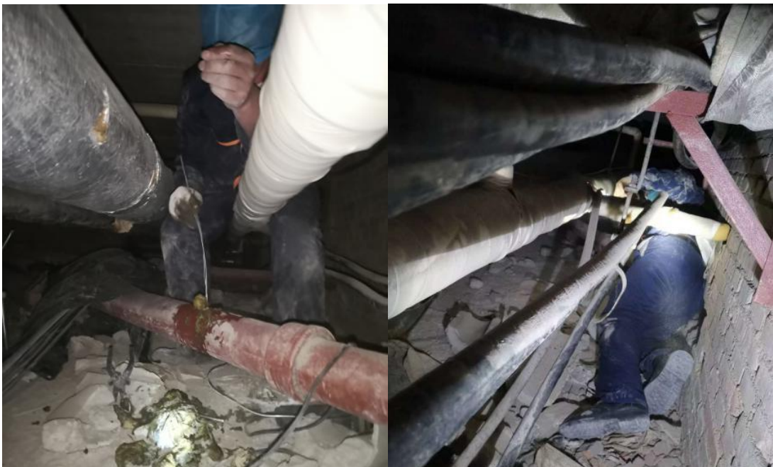
图 12.2 号楼（南楼）设备夹层空间狭小抢修困难
