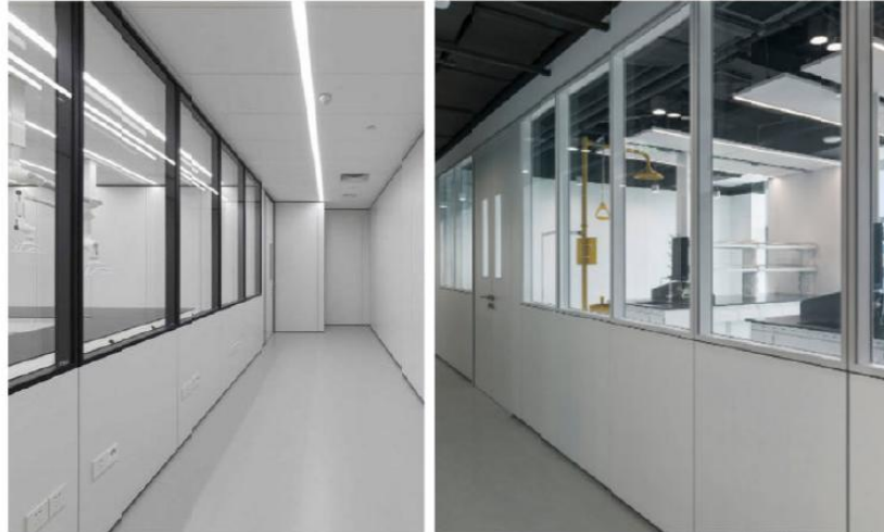
铝合金玻璃隔断及隔断门示意图
