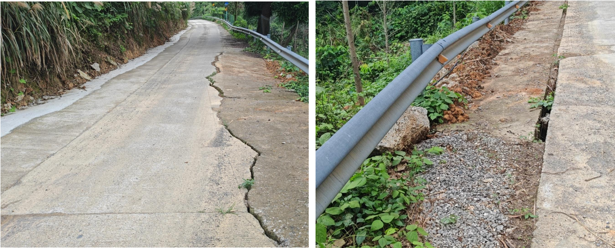
Y594 线 K3+860-K3+940 段水毁现场灾毁照片
