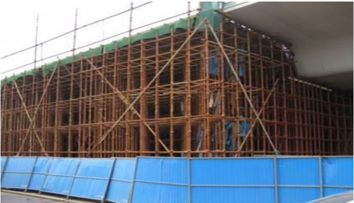
现浇大箱梁满堂支架法施工
